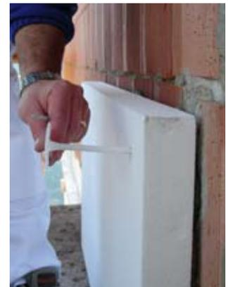
A questo punto si procede con l'inserimento del tassello che dovrebbe avvenire in maniera semplice e senza ausilio di martelli. Nel caso il tassello non penetrasse interamente verificare che la foratura sia stata eseguita correttamente (con la giusta profondità).
